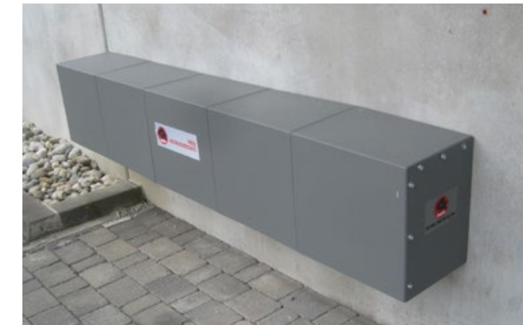
Coffre résistant aux intempéries pour le stockage des batardeaux
