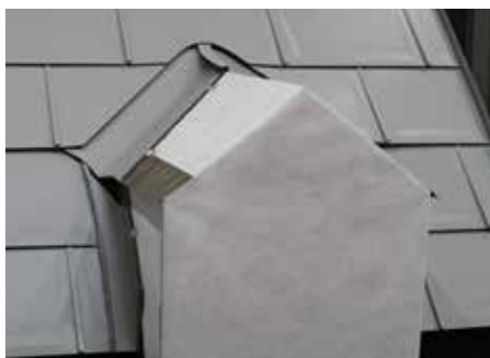
Dachplatte R.16 Kehle, seitlicher Wandanschluss
