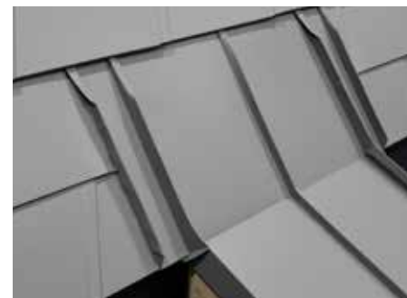
Dachschindel DS.19 Anschluss an Stehfalz
