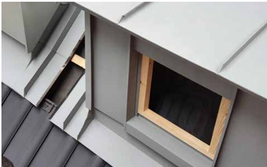
Gaubenfront und -eindeckung in Stehfalz-Ausführung
