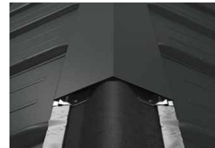
Abbildung 71 • Firstausbildung mit einfacher Firstkappe
